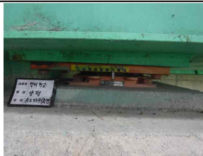
⑤ A2-Sh4 받침 이동위치 측정
