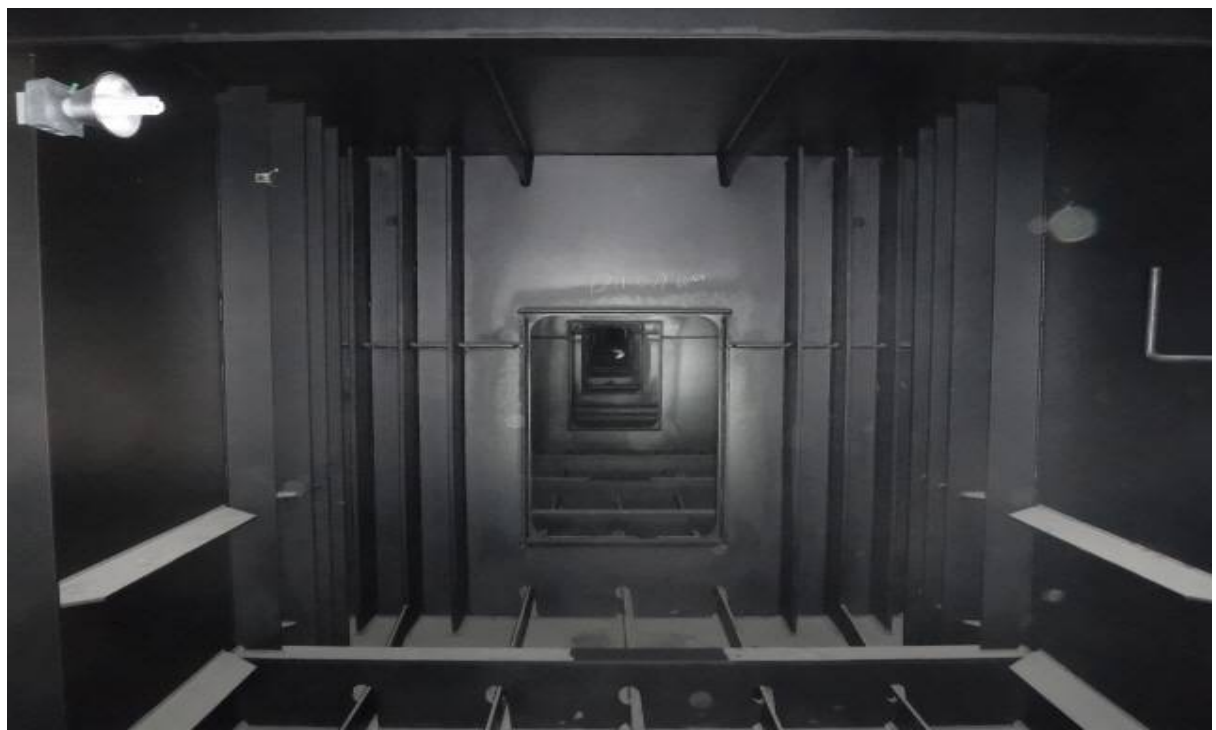
강박스 내부 전경
